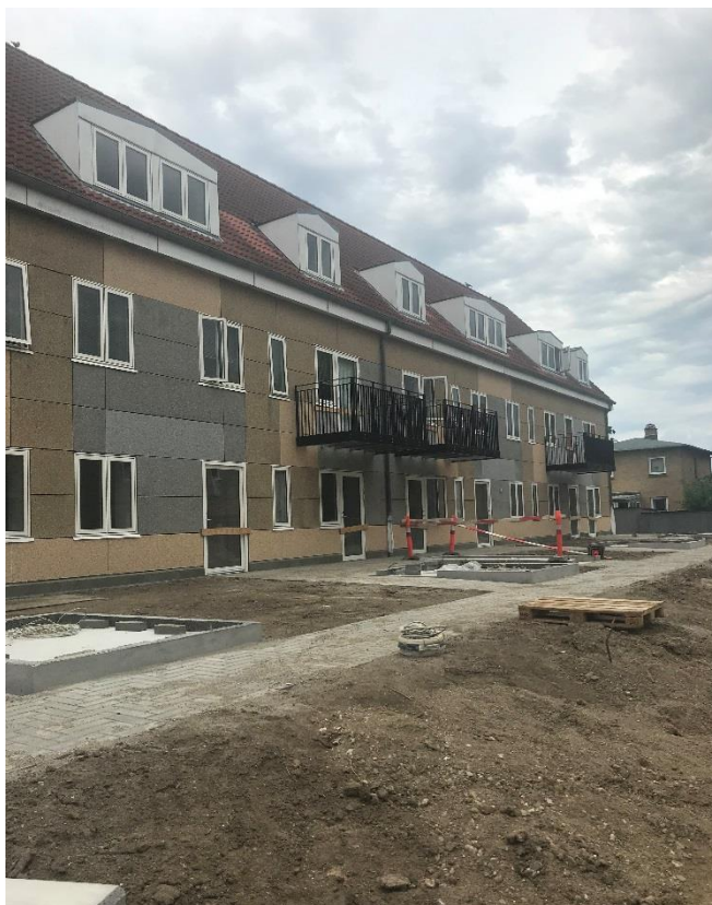
Arbejder bag ved blok E mangler fortsat.
