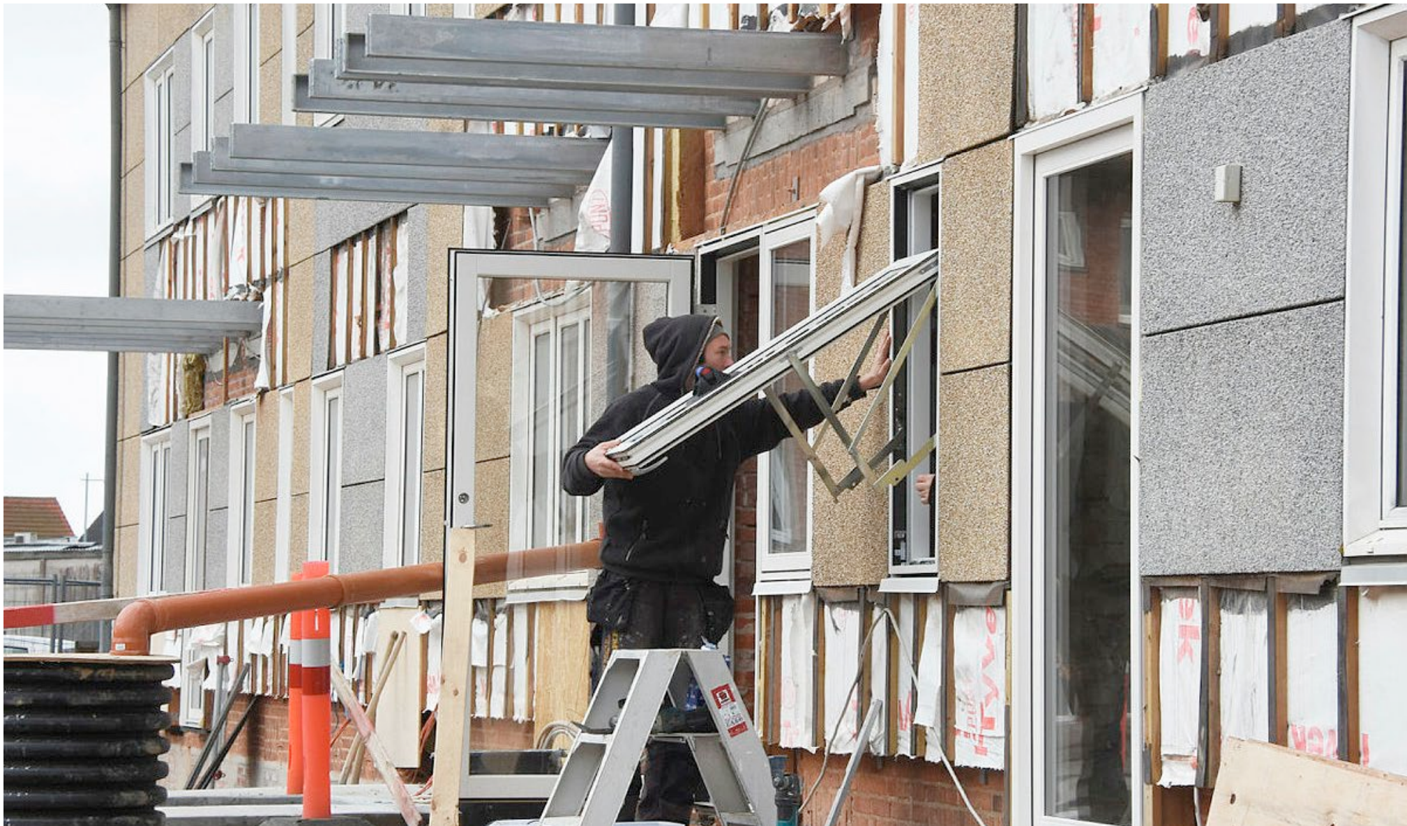
Den nye boligrenoveringsaftale vækker ikke umiddelbart voldsom begejstring hos de lokale boligselskaber. Billedet her er fra en tidligere renovering af nogle af Nykøbing F. Boligselskabs boligblokke i Teglværksgade i Nykøbing.
