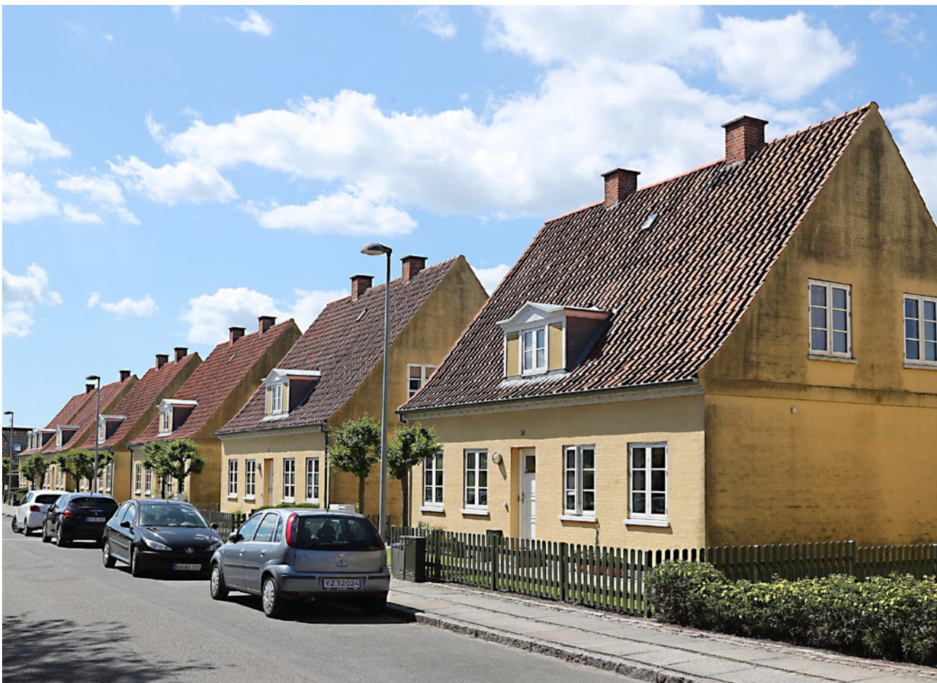
Boligerne på Tietgensvej er opført i 1925. Der er tale om otte toværelses lejligheder samt 16 treværelses lejligheder, der blandt andet skal have nyt køkken og bad.
