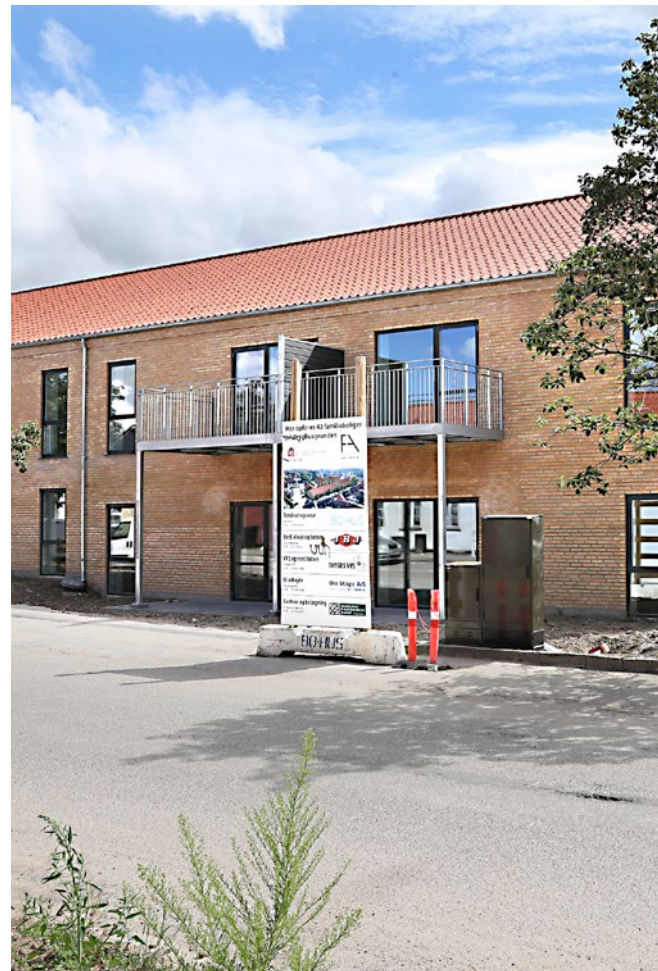
Bohus har stået for byggeriet af de nye boliger.
