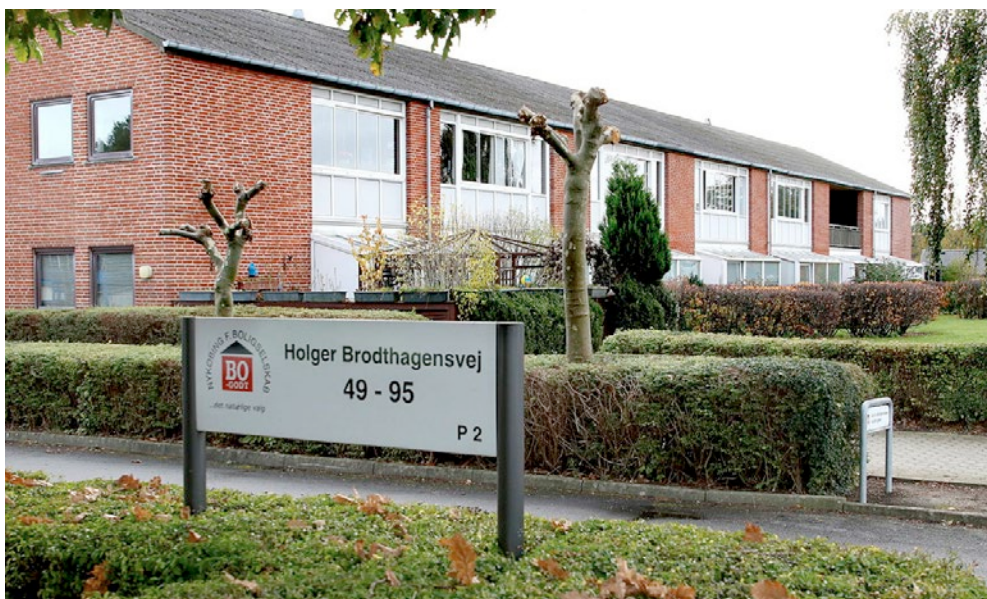
Nykøbing F. Boligselskabs afdeling 13 på Holger Brodthagensvej står foran en stor renovering.
