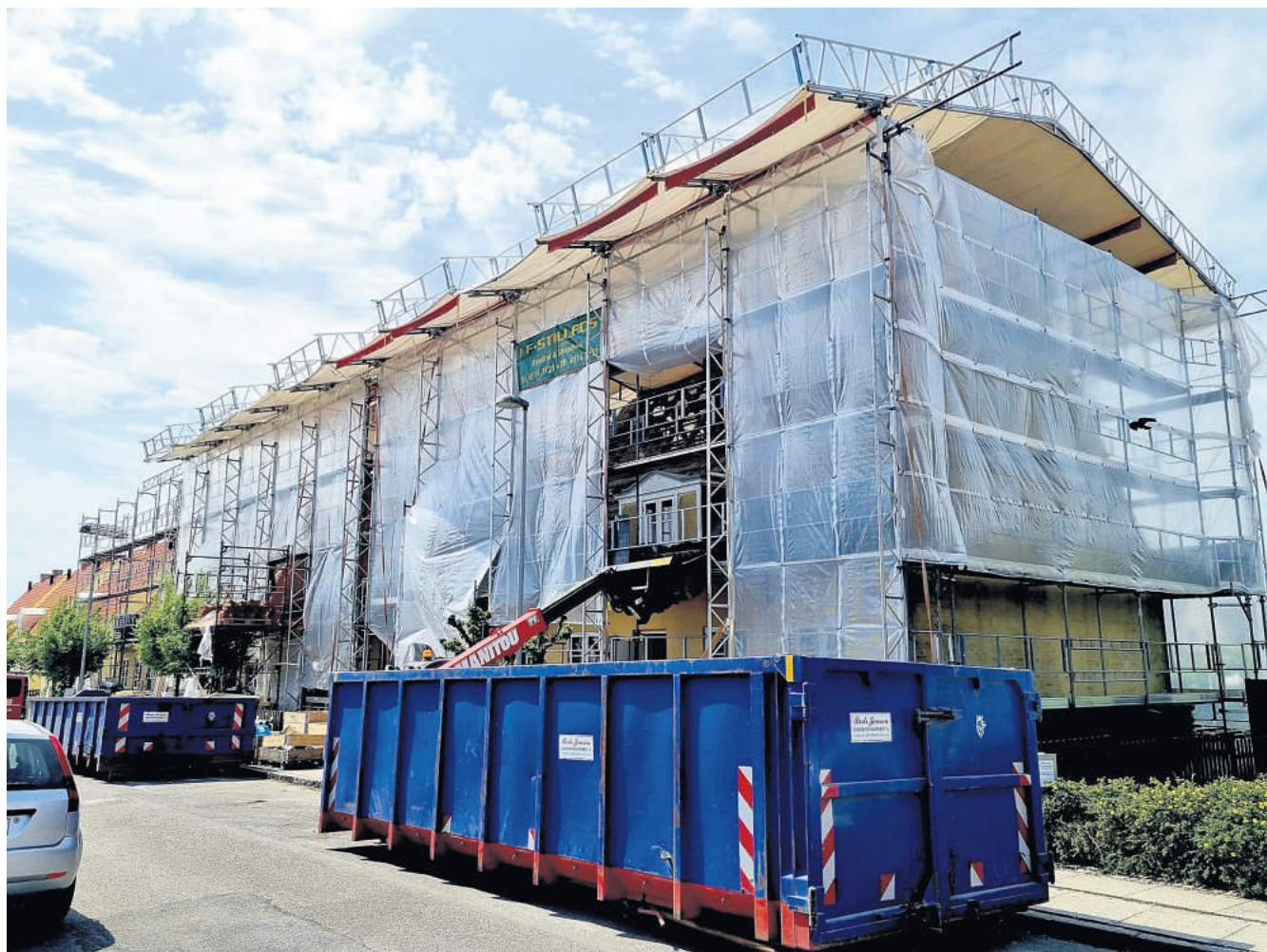
Boligselskabet er i gang med en omfattende og meget dyr modernisering af boligerne på Tietgensvej. Næsten to millioner kroner pr. bolig koster renoveringen. Det er M.N. Entreprise, der står for arbejdet. Foto: Claus Hansen
