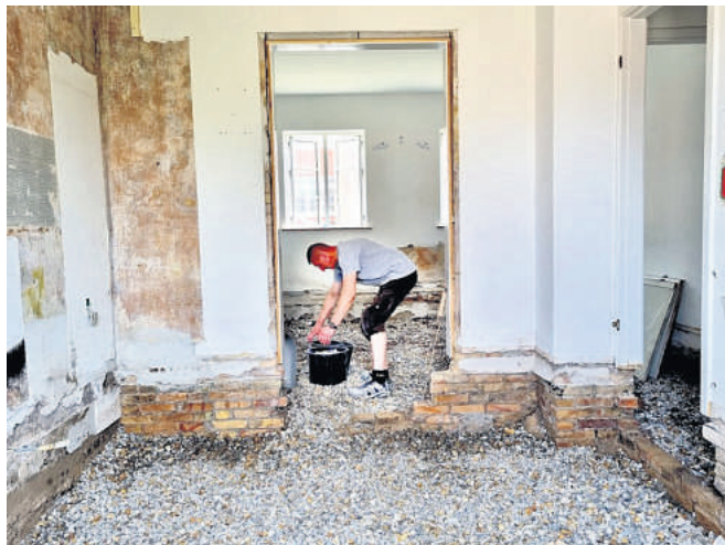
24 boliger på Tietgensvej renoveres. Foto: Claus Hansen
